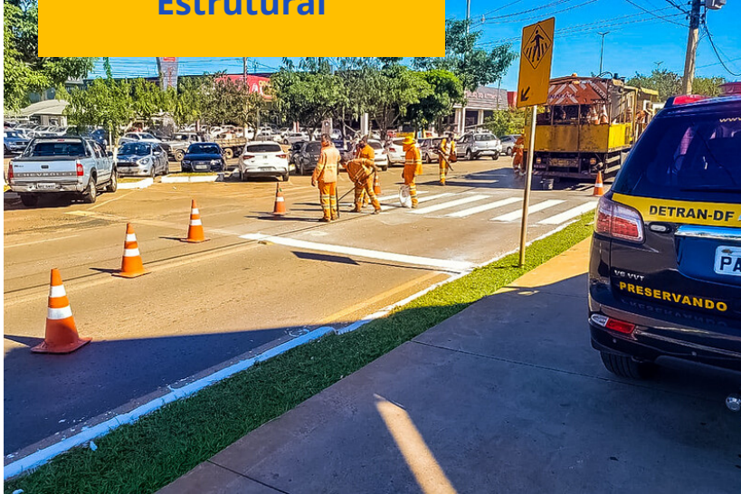
Pintura de faixas na Estrutural
