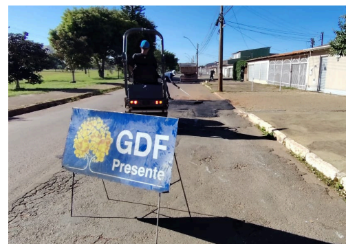
Operação tapa-buraco na QNM 38 Conj U da M Norte
