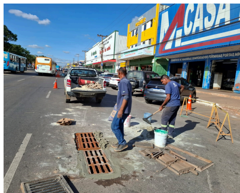
Reposição de grelha na QI 01 da Avenida Hélio Prates
