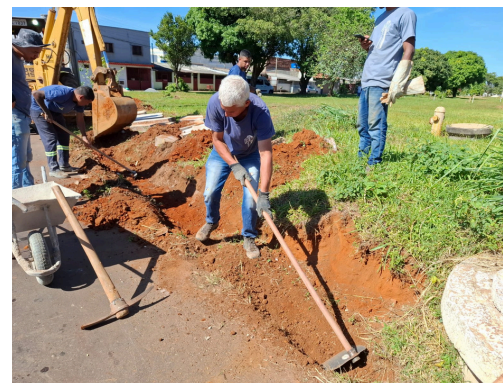
Colocação de meio-fio na QNM 34 Conjunto G2, da M Norte
