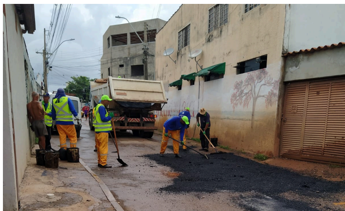
Operação emergencial de tapa buracos no Setor Nova Colina 2, em Sobradinho. Trabalho com apoio do DER.
