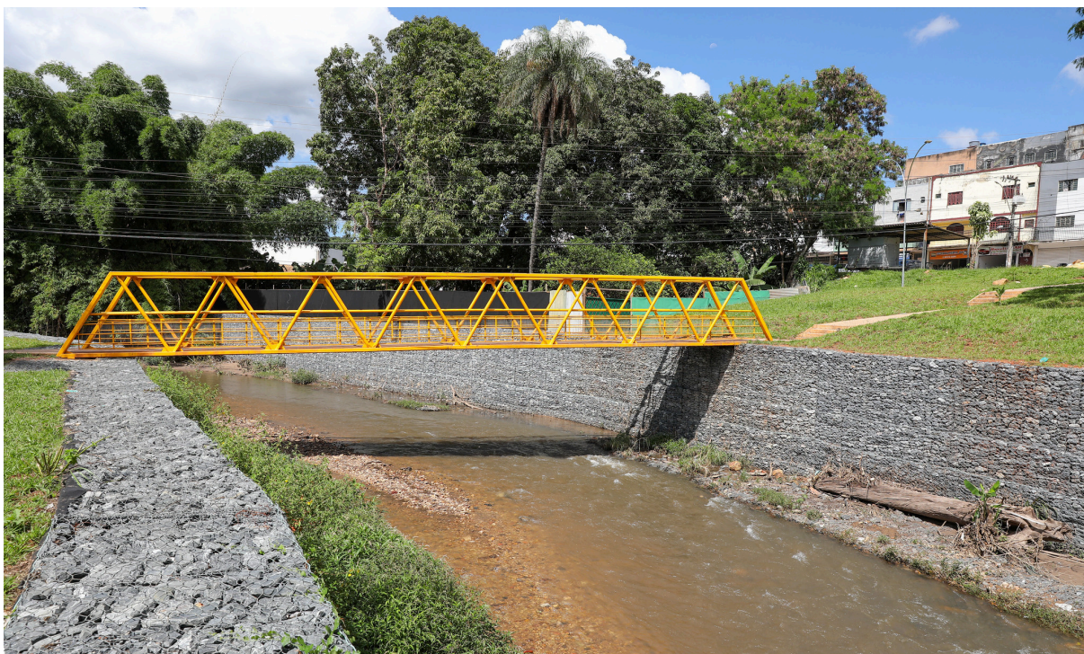
Ponte Liverpool foi arrastada no início de janeiro de 2024.
