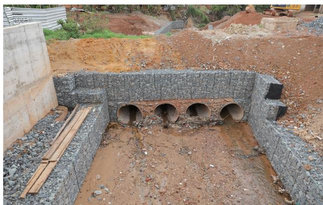
**Obra de contenção com gabiões na ponte de ligação entre o Trecho I e Trecho II do Sol Nascente.**
