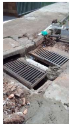
Recuperação de boca de lobo na QR 203 Conjunto E
