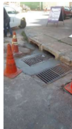
Recuperação de boca de lobo na QR 203 Conjunto E
