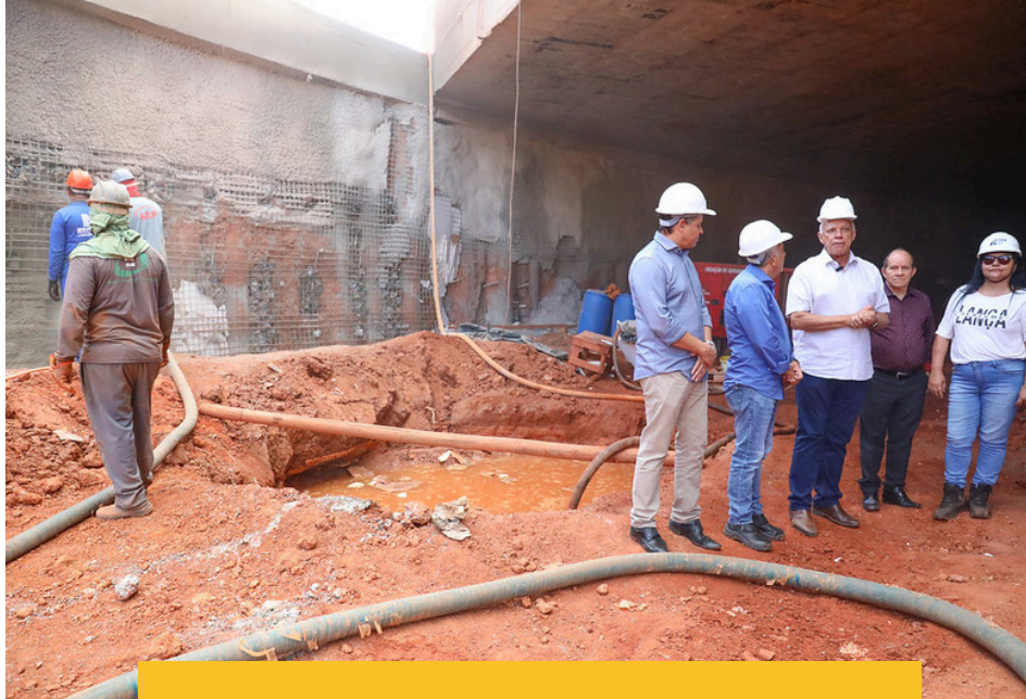
Equipes do GDF visitam obras do Viaduto do Riacho Fundo
