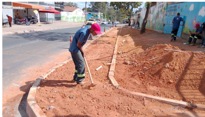
Reconstrução de calçada na QSE 18 Lote 01, em Taguatinga Sul
