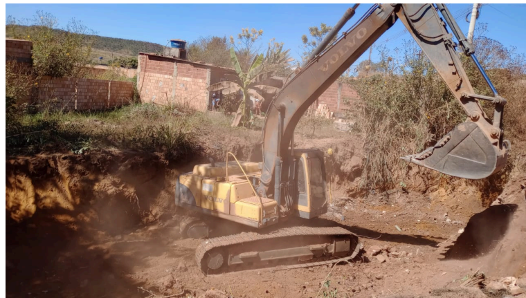
Obra de implantação de bueiro de travessia de pista, no bairro Capão Comprido. O local, de grande fluxo de veículos, principalmente ônibus escolares, estava com risco de acidente devido às fortes chuvas terem causado o rompimento das manilhas.
