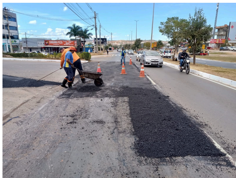
Foram aplicadas 172,06 toneladas de massa asfáltica na recuperação de vias da RA.
