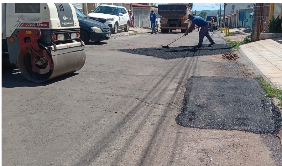
Na recuperação asfáltica na QNO 06, conjunto P, foram utilizados 4.950kg de massa. No mês de abril, foram 124.270kg de massa em toda a região administrativa.
