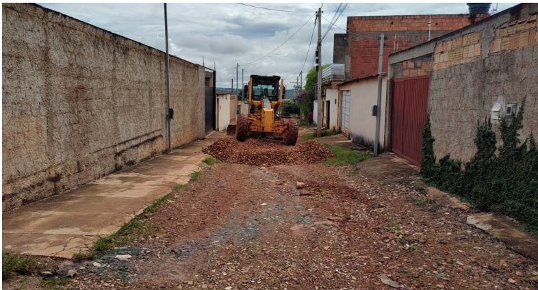
Manutenção de vias não pavimentadas na quadra 56 - rua 01, do Bairro Morro da Cruz.
