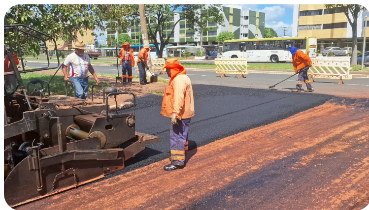
Manutenção viária na Área Especial da QNL 7, na via de ligação LJ1 com LJ2.
