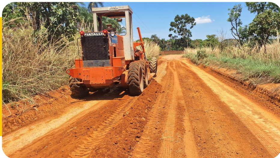
A melhoria de 5 km de estrada não pavimentada do assentamento Canaã beneficiou produtores rurais e estudantes da Escola Classe Chapadinha. O ajuste da via foi feito com a colocação de 400 toneladas de material RCC, espalhamento e nivelamento com a utilização de caminhão pipa. As equipes construíram bigodes para escoamento e bacias para contenção de águas pluviais.
