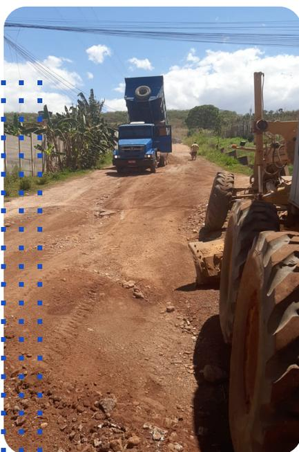
A QN 07 do Riacho Fundo foi um dos endereços da RA que recebeu equipe da Novacap para o trabalho de recuperação do asfalto danificado. As vias não pavimentadas do Núcleo Rural Kanegae receberam material RCC para nivelamento. O Polo Sudeste também trabalhou na manutenção das estradas de terra do CAUB 2.
