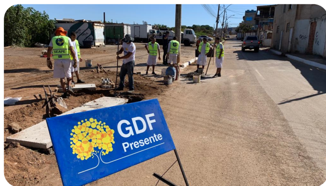
Limpeza de bocas de lobo na Estrutural
