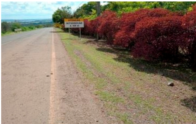
Roçagem em um trecho de 20,9 km da rodovia DF 445, em Brazlândia
