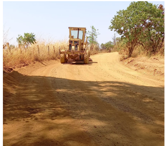
Manutenção de vias não pavimentadas no Núcleo Rural Aguilhada
