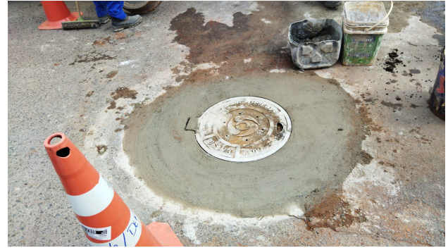
Limpeza e reposição de tampa de esgoto na quadra 5, conjunto D, do Varjão
