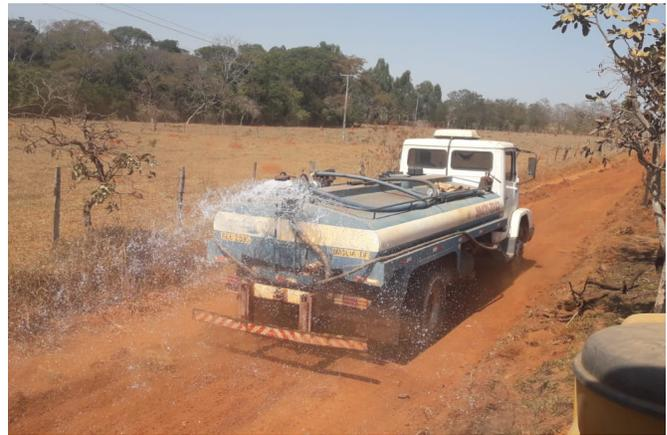
O Polo Leste concentrou máquinas e equipes na área rural de Sobradinho dos Melos. Viciniais foram recuperadas com a colocação de mais de 140 toneladas de material RCC, terraplanagem e patrolamento. O ajuste melhorou as condições para trafegar nas vias e facilitou o acesso à escola classe da região. Também por lá, um caminhão pipa espalhou água para diminuir a poeira.
