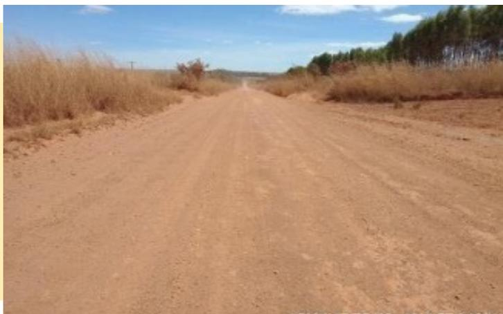
**Na DF 220, também houve a reconformação do leito estradal com patrolamento, encascalhamento e ações de melhoria nas saídas de água.**
