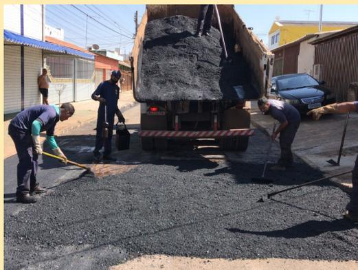
**Restauração do asfalto na QNM 3 e Via N1 Norte. Foram aplicadas 71.9 toneladas de massa asfáltica.**
