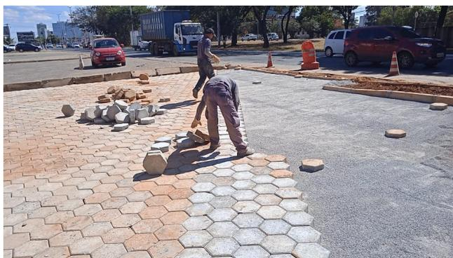
Uma ação repetida em alguns locais foi a construção de estacionamentos com bloquetes de concreto pré-moldados, melhorando a organização do trânsito. Na QNG, o espaço tem 192 metros quadrados e vai abrigar 11 vagas. Na CSE 6 (foto ao lado), são 29 novas vagas numa área de 500 metros quadrados.
