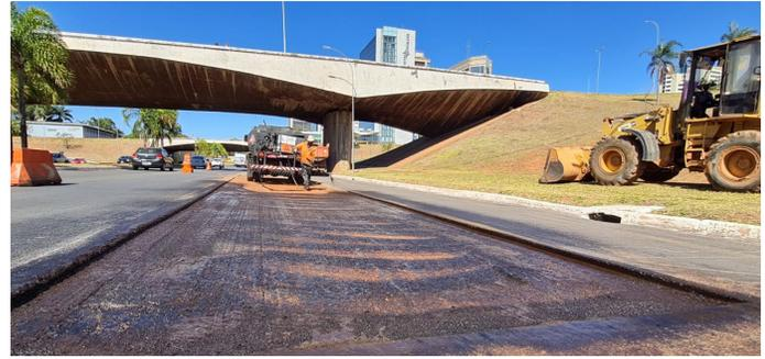
**Recapeamento asfáltico na ligação da W3 Norte à W3 Sul**
