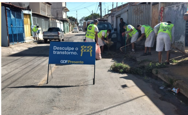
Frisagem e capina na QN 01 conjunto 21
