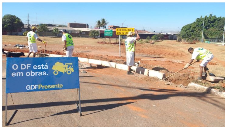
Implantação de meios-fios na Praça da quadra 310
