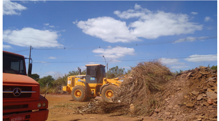
Recolhimento de entulhos do transbordo irregular na Granja do Torto
