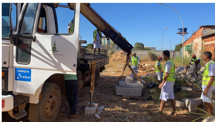
Com o Polo Oeste II, Mãos Dadas ajudou no transporte de meios-fios para instalação na Praça da QNC 7
