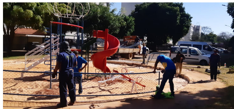
A reforma do parquinho da Quadra 905 do Cruzeiro Novo incluiu o conserto e a pintura do alambrado, e troca do balanço, escorregador e gangorra
