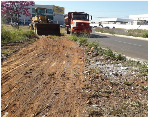
Recolhimento de entulho na ADE
