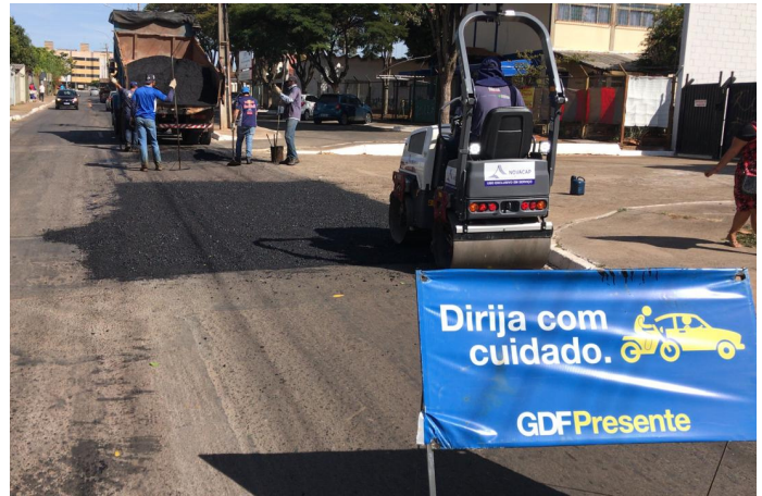
Sete toneladas de massa asfáltica foram usadas na restauração do pavimento na QNL 7
