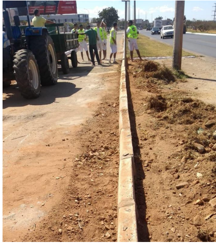
Instalação de meios-fios na quadra 378 do condomínio Del Lago
