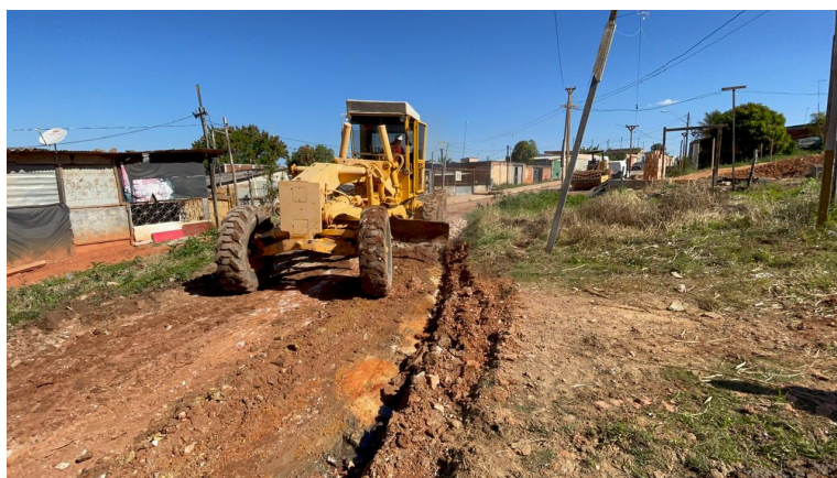
Terraplanagem nas ruas não pavimentadas do condomínio Porto Rico
