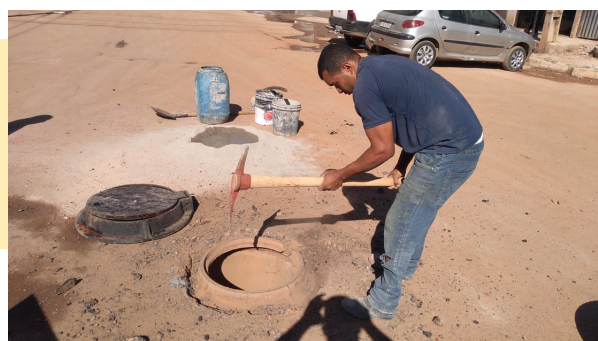
Substituição de tampas e grelhas
