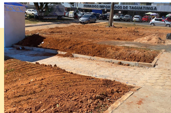
Colocação de meios-fios na Praça da QNC 7
