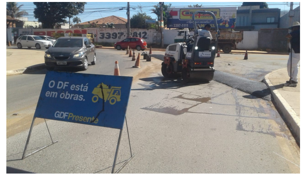
Construção de quebra-molas na Rua 12/7
