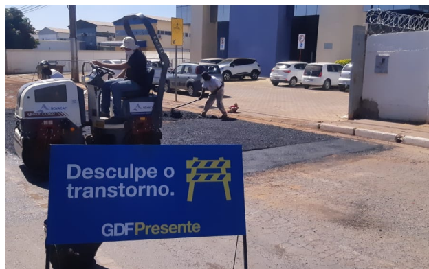
Recapeamento do asfalto no SAAN
