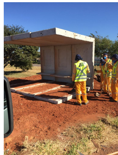
Colocação de abrigo do ponto de ônibus na DF 425
