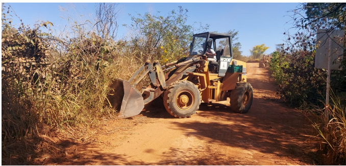
Reparo da ponte que liga o CAUB 1 à Escola IPÊ
