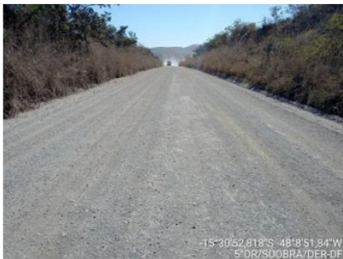
Na DF 206, o Polo Rural fez a reconformação do leito estradal, com encascalhamento e saídas d'água
