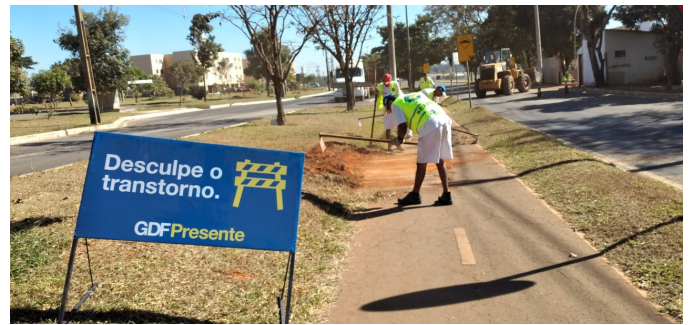
Capina e frisagem na ciclovia da QN 15
