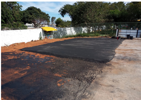
Construção de estacionamento do CAIC
