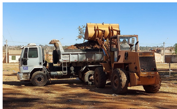
Carregando entulho e inservíveis no anel viário
