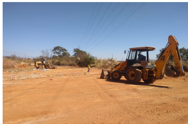
Recuperação de área de transbordo irregular no Condomínio Privê, próximo à BR-070.
