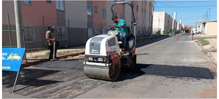
Construção de ondulação transversal na QN 25 conjunto 10
