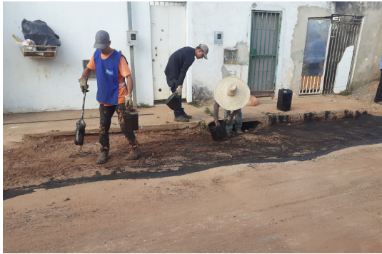
Operação tapa-buraco na quadra 59 do condomínio Del Lago
