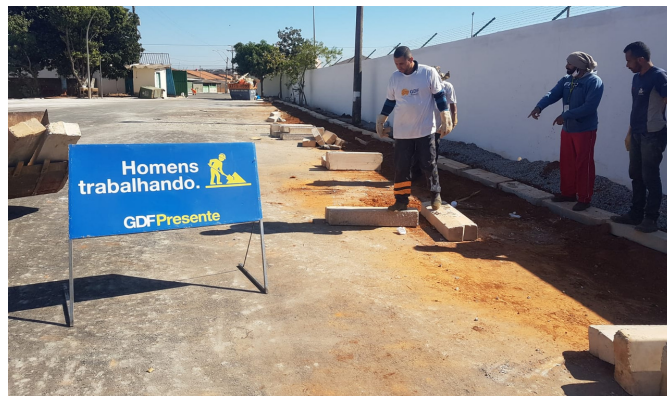
Instalação de meios-fios no Caic Júlia Kubitschek de Oliveira
