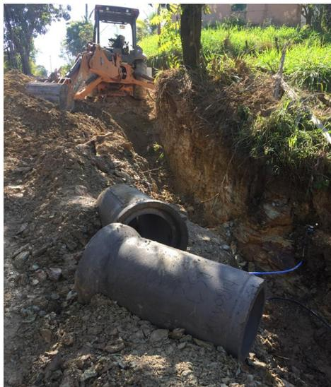
**Preparo do solo, nivelamento, limpeza e colocação de manilhas para a pavimentação em bloquetes, na Rua do Mato**
