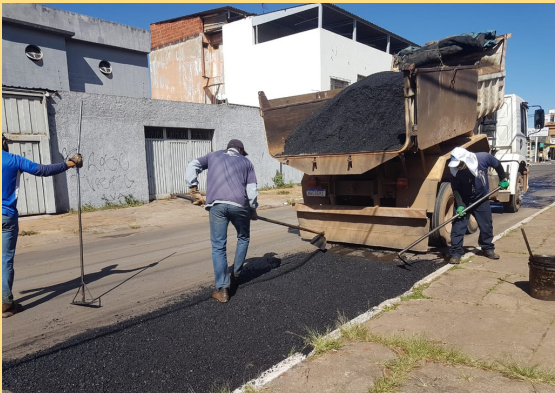
Aplicadas 10.7 toneladas de massa asfáltica na restauração do pavimento nas QNA 3, 5, 7, 9, 11 e 13.
