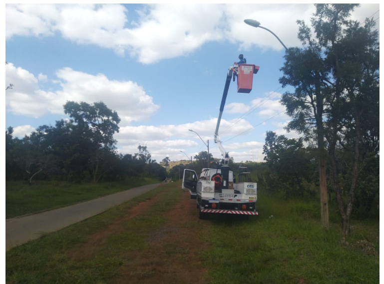
Troca de lâmpadas convencionais por LED na travessia do parque
