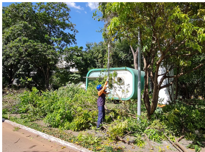
Poda de árvores na 416/216 Sul. O trabalho foi realizado para facilitar a remoção do antigo posto de polícia.
