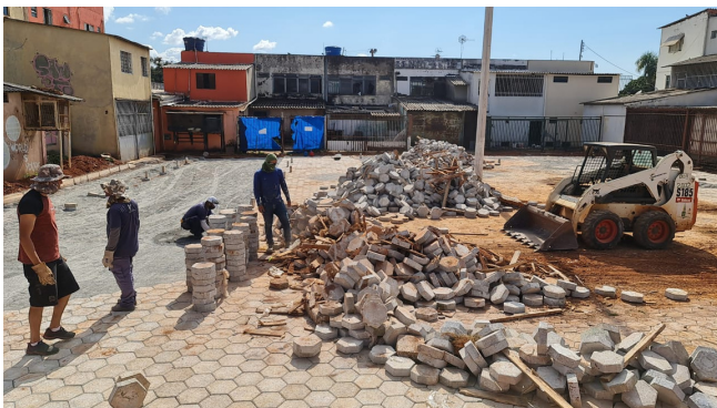
Construção de estacionamento com bloquetes na EQNM 36/38
