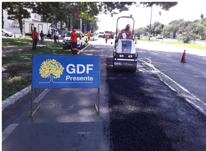
Asfalto da L2 Sul está sendo recuperado
