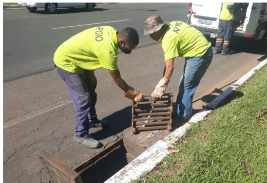
Conserto e substituição das grelhas de ferro na QL 10
