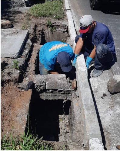
Limpeza, manutenção e reforma de bocas de lobo na QNL 1
