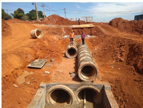
Reconstrução de rede de águas pluviais na Via O8 na BR-070
