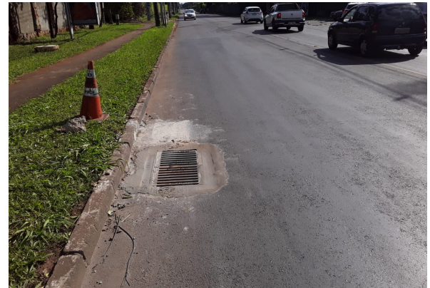
Reposição de grelha de bocas de lobo na QI 05
