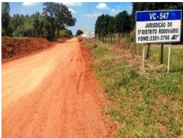
A estrada de terra da VC - 547, na região de Brazlândia, teve 5,8 quilômetros de patrolamento e recebeu encascalhamento
