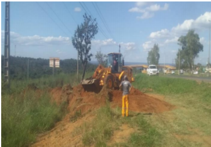
Recuperação de erosão nas margens da BR-020, sentido Planaltina
