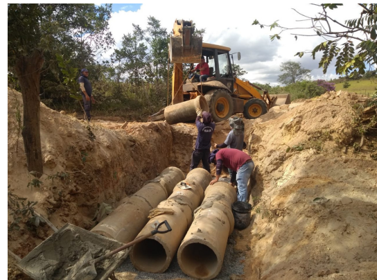
Construção de bueiros para captação de águas pluviais no Núcleo Rural Monjolinho
