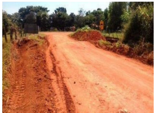
A estrada de terra da VC - 547, na região de Brazlândia, teve 5,8 quilômetros de patrolamento e recebeu encascalhamento
