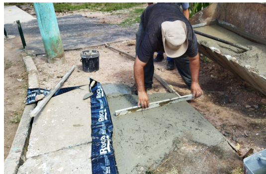
Finalizando a construção de uma calçada com rampa de acessibilidade
