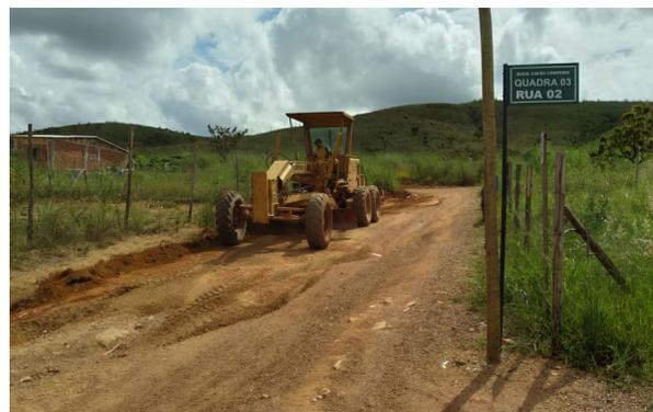
**Ajustes de estradas de terra na quadra 03 do Capão Comprido. Foram utilizadas 20 toneladas de material no ajuste da via**
