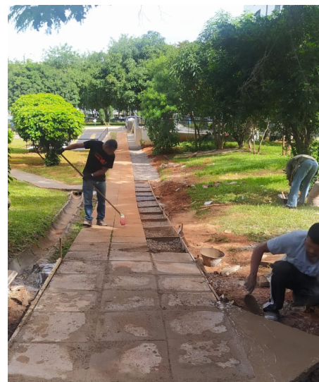
Revitalização das calçadas na SQSW 103
