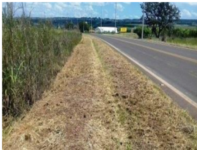
Serviço de roçagem na Rodovia DF - 430, em Brazlândia. O trabalho foi feito nas margens de 10,7 quilômetros da pista.
