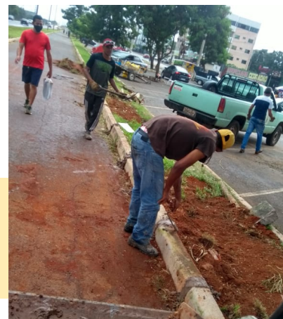
Manutenção de meios-fios na ciclovia da DF-250
