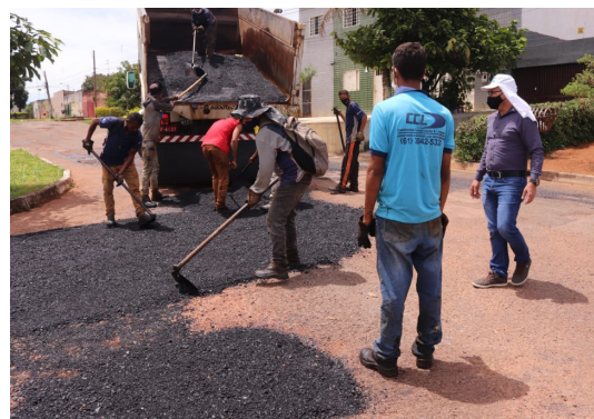
Asfalto recuperado na quadra 12 do Setor Sul
