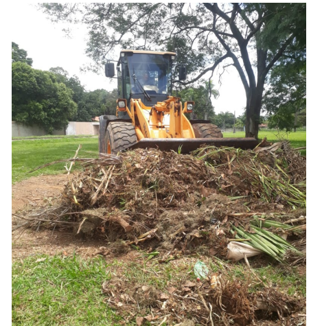
Foco na limpeza com a retirada de entulho
