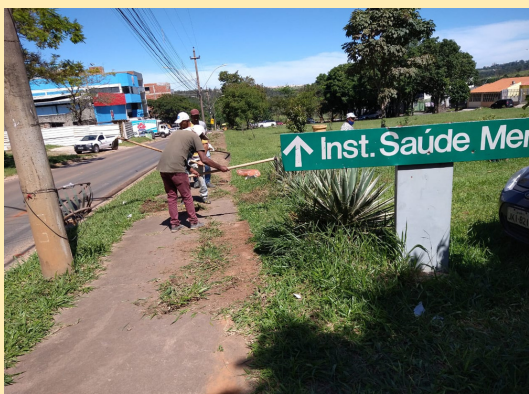
Capina e limpeza de calçadas
