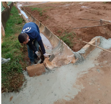
Implantação de canaletas para escoamento de águas pluviais na QNR 2
