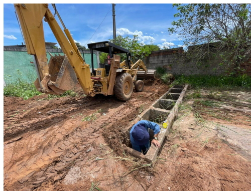
Reposição de tampas de boca de lobo
