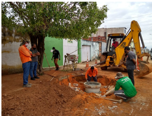
Recuperação de assoreamento da rede de águas pluviais no Condomínio Privê
