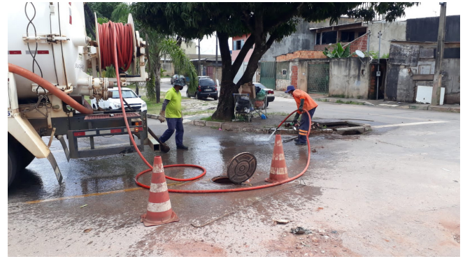
Desobstrução da galeria de águas pluviais na quadra 05
