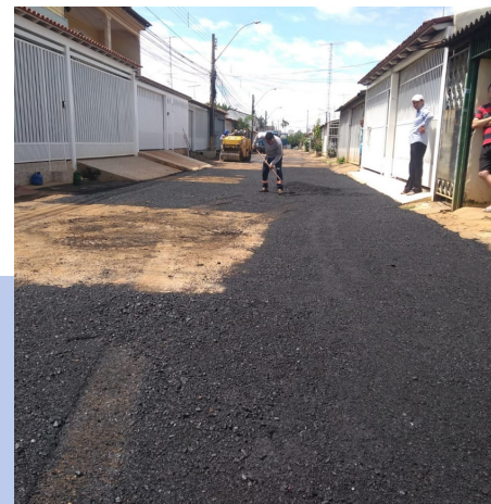
67 toneladas de massa foram usadas na restauração do asfalto.
