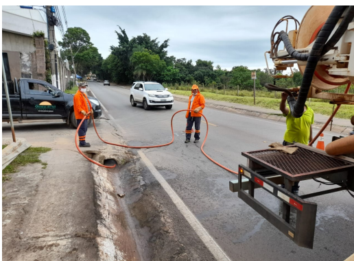
Limpeza de boca de lobo na Avenida Nacional
