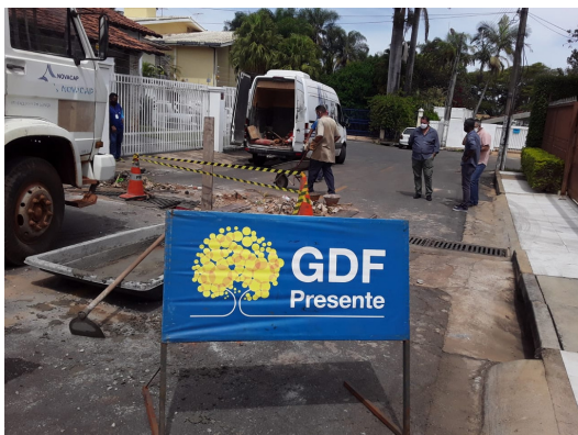
Reconstrução de bocas de lobo na QI 07 conj 13
