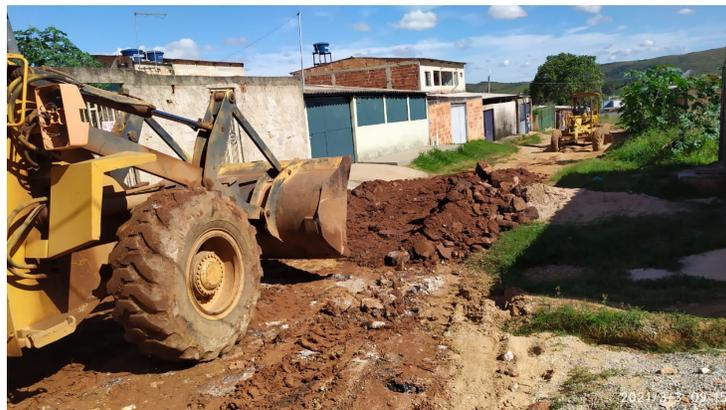
**300 toneladas de material foram usadas na terraplanagem e ajustes das ruas não pavimentadas.**
