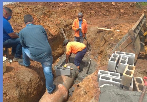
Na entrada de Água Quente, o volume de chuva formou um grande bolsão de água. As equipes do GDF Presente fizeram drenagem da água acumulada e construíram rede fluvial para o escoamento da água e bocas de lobo. A obra vai evitar água parada e a proliferação do mosquito transmissor da dengue.
