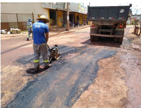
**Foram aplicadas seis toneladas de massa asfáltica na operação tapa-buraco.**
