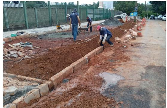
**Construção de calçadas com bloquetes no estacionamento do Setor QNC, próximo ao HRT e Hospital Anchieta**
