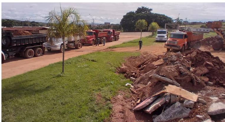
Grande operação com oito caminhões, dois rolos pata, duas patrols, um caminhão pipa, uma van de apoio e 20 trabalhadores para conter uma erosão de oito metros de profundidade na rua 13 do Capão Cumprido. Também, foi feita a compactação do solo e terraplanagem com aplicação de 500 toneladas de restos de construção civil e material grosso, como pedras.
