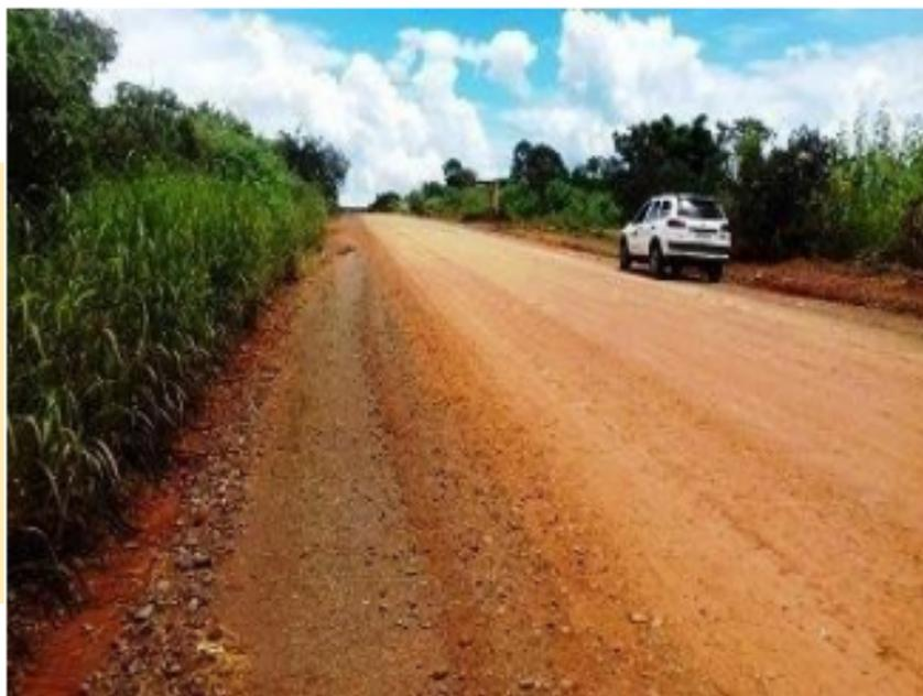
Melhoria de estrada na DF - 220, em Brazlândia. Foram patrolados 13,6 Km em três diferentes trechos e construídos 231 bigodes para evasão da água da chuva.
