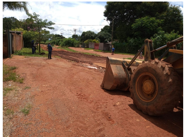
Retirada de entulho
