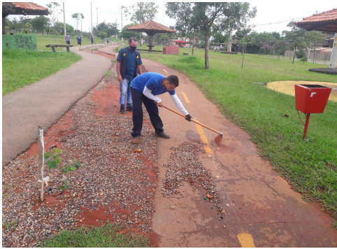
Desobstrução e limpeza de ciclovia no Taguaparque
