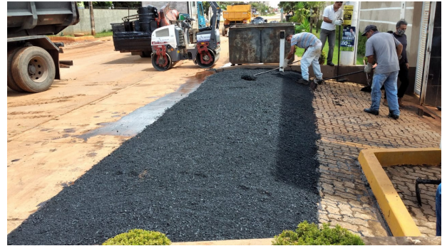
Contenção para evitar entrada de água no condomínio 131B
