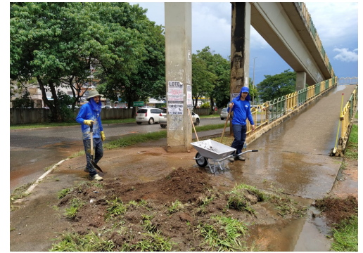
Limpeza de passarela na CSE 11 no Pistão Sul
