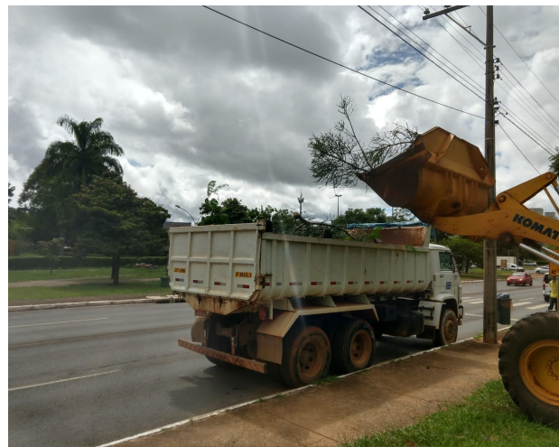
Limpeza de entulho e inservíveis
