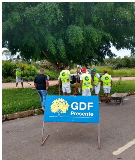
Limpeza de bocas de lobo no Setor Buritis 4 e Avenida das Feiras
