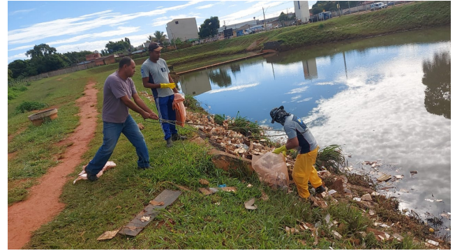
Limpeza das bacias de contenção
