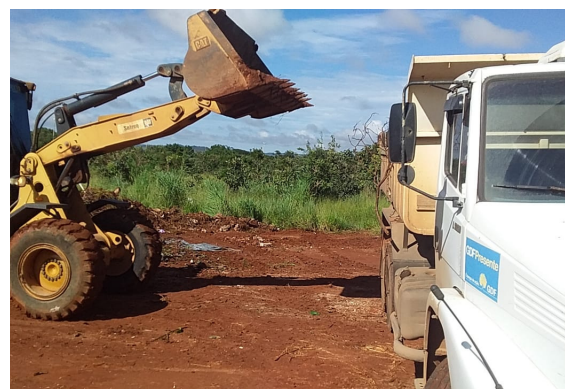
Retirada de 56 toneladas de entulho e limpeza de transbordos irregulares no Jardim Roriz
