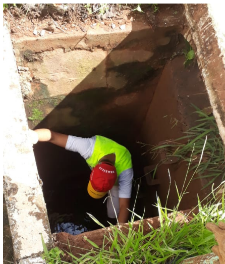
Limpeza de bocas de lobo
