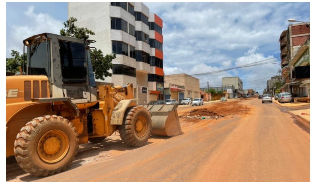
Limpeza e retirada de entulho na Rua 12, que recebeu várias ações de melhoria após os danos provocados pelas chuvas. Lá foram colocadas 1.055 toneladas de material grosso na rua 12, para recuperar a via.
