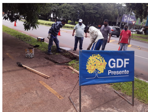
Limpeza de bocas de lobo na 103 Norte
