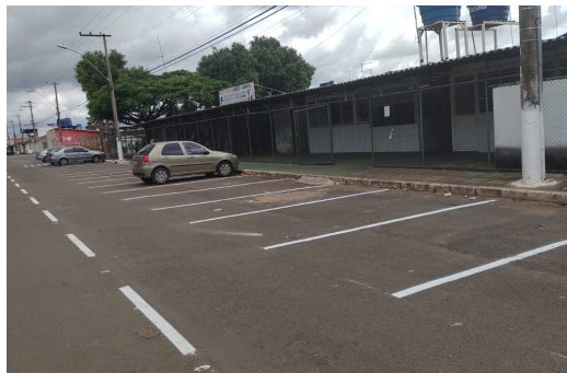
Sinalização horizontal na Feira da Guariroba P Sul
