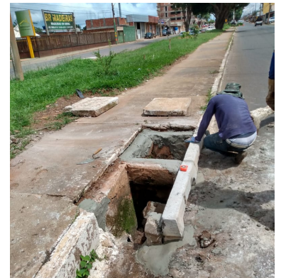
Manutenção de boca de lobo na Via P 2 Norte
