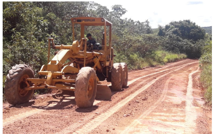
Terraplanagem e ajustes de vias no Altiplano Leste
