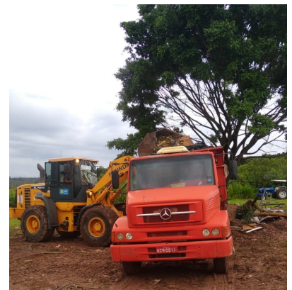
Retirada de entulho na quadra 11
