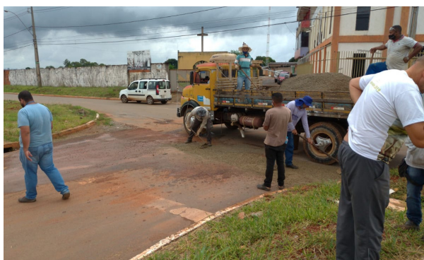
Reparos nas vias do CAUB 01
