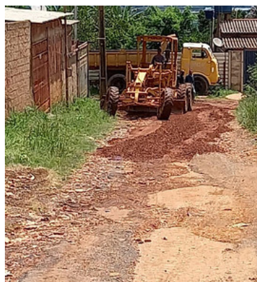
Terraplanagem na quadra 701
