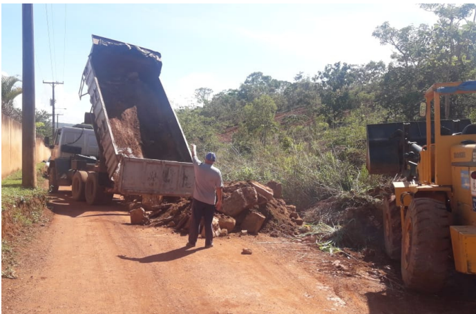
Em um dia foram usadas 100 toneladas de material pesado para conter erosões em via não pavimentada no Núcleo Rural Santa Luzia.
