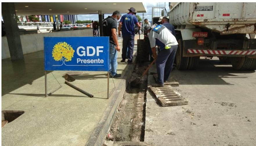
**Limpeza das galerias de água pluvial**
