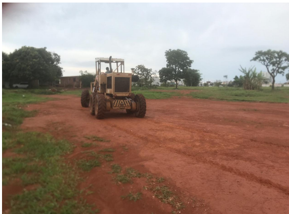
Terraplanagem de campo de futebol, na Vereda da Cruz
