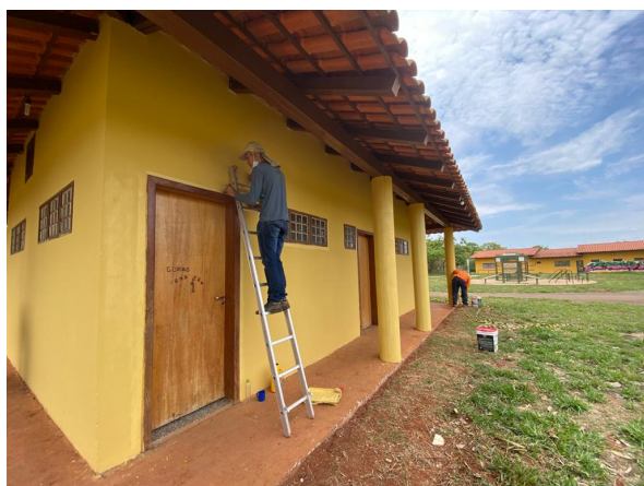
Pintura e manutenção do banheiro coletivo
