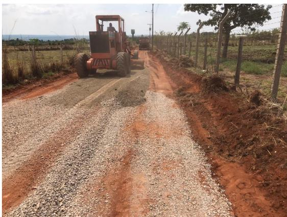
E o ajuste das vias sem pavimentação começou na Travessa 2 do Lago Oeste, na região administrativa de Sobradinho II. Inicialmente serão colocadas 200 toneladas de expurgo de brita. As equipes do Polo Norte também iniciaram limpeza das bacias de contenção, a construção de saídas de águas pluviais e o abaulamento da pista – que é fazer curvatura nas bordas da via, conduzindo as águas da chuvas para fora dela.
