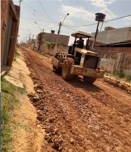
Recuperação de estrada vicinal no núcleo Rural Boa Esperança, com a eliminação de uma erosão de 12 metros de profundidade.
