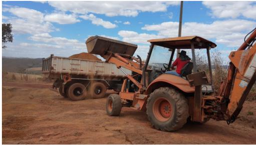
Reparos na estrada rural do Capão Comprido com nivelamento, brita e instalação de um sistema de drenagem de água pluvial. O serviço vai garantir a fluidez na mobilidade dos 18 mil moradores da área.
