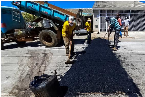
Nos conjuntos 5/6 e 6/7 da QN 18 dois quebra-molas foram construídos com três toneladas de massa asfáltica.
