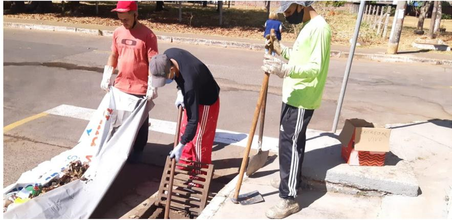
**A manutenção chegou a toda a galeria de águas pluviais com a limpeza e desobstrução de 300 bocas de lobo nas quadras 4, 6, 8, 10 e 12 e no Cruzeiro Center. Dezenas de grelhas de concreto que estavam quebradas foram substituídas.**
