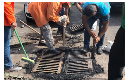
Manutenção de boca de lobo no setor de oficina
