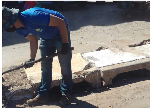
Recuperação de bocas de lobo
