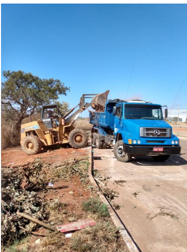
Retirada de entulhos no Polo JK
