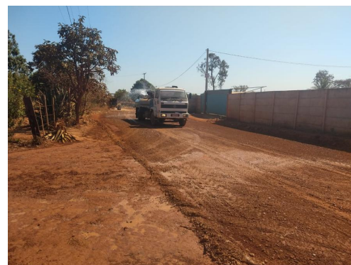
Terraplanagem na área rural de Olhos D'água
