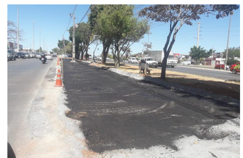
Recuperação de estacionamentos
