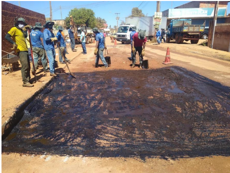
Operação tapa buraco na Avenida Morro da Cruz
