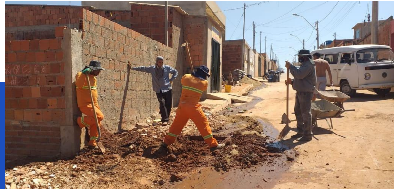
Abertura de bocas de lobo na chácara 94, trecho 2
