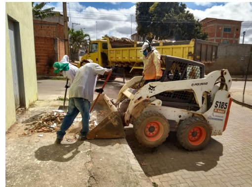
Retirada de entulho na QL 04
