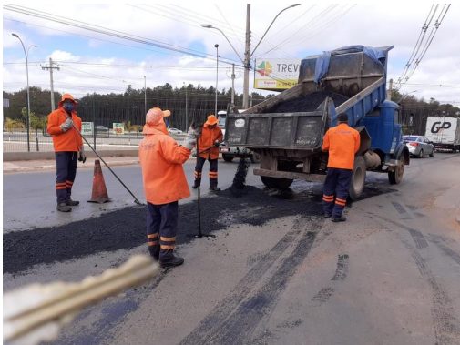
Operação tapa-buracos realizada na quadra 01 da Fazendinha
