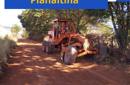
2,5 km de patrolamento e ajustes de vias sem pavimentação no Núcleo Rural Aprodarmas. Além de limpeza de uma bacia de contenção e a construção de saídas de águas pluviais.
