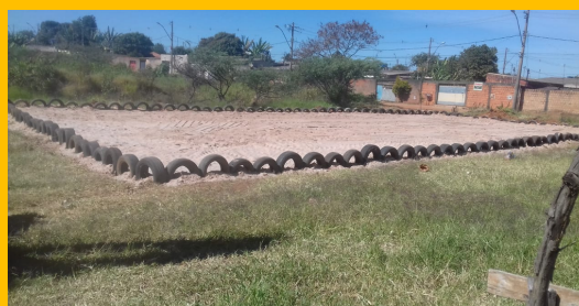
Construção de uma quadra de areia no Setor Lagoinha, na chácara 1 no trecho 3
