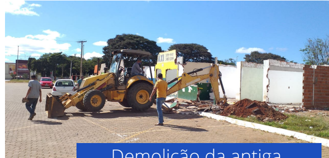
Demolição da antiga rodoviária
