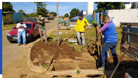
Recuperação de boca de lobo no Incra 8
