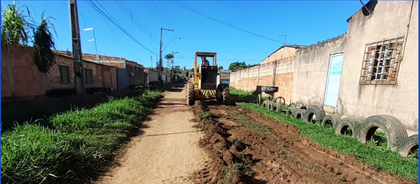
Polo Sul recuperando estradas em Água Quente, na região do Recanto das Emas.
