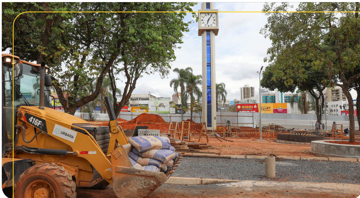
Execução do paisagismo nas obras da Praça do Relógio - Divulgação Agência Brasília
